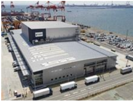
不動産のデジタル証券 ～神戸六甲アイランドDC～ (譲渡制限付)
